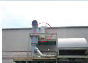
Silencer และวัสดุกันเสียงบริเวณ PA Compressor
