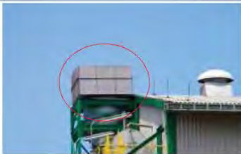
Silencer และวัสดุกันเสียงบริเวณ PA Compressor
